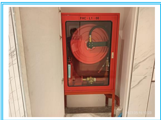
รูปที่ 3-51 ตู้เก็บสายฉีดน้ำดับเพลิงพร้อมอุปกรณ์ (Fire Hose Cabinet : FHC)
