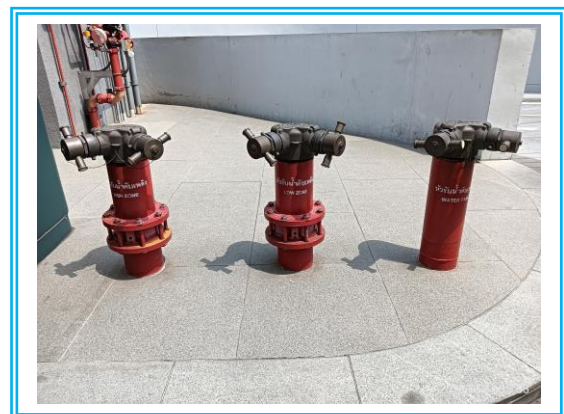
รูปที่ 3-50 หัวรับน้ำดับเพลิงภายนอกอาคาร
