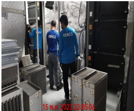
รูปที่ 3-41 การทำความสะอาดแผ่นกรองอากาศ
