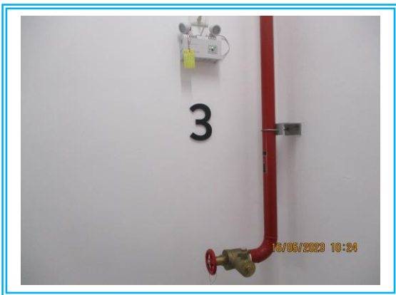
รูปที่ 3-49 ระบบท่อเย็น ระบบดับเพลิง
