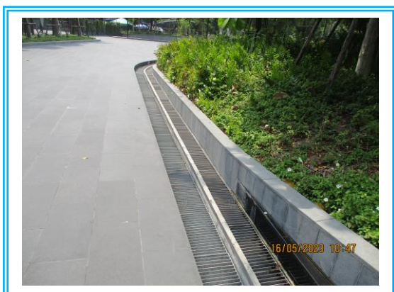
รูปที่ 3-74 ตะแกรงครอบท่อระบายน้ำ
